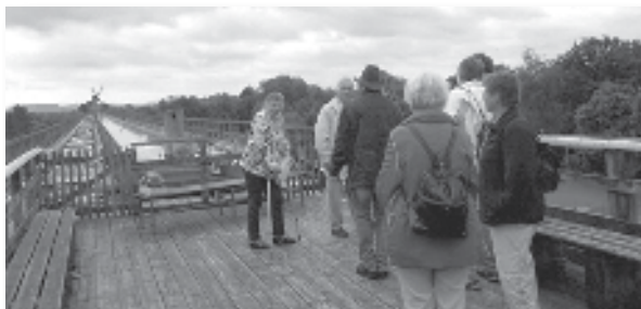
2016: Auf dem Gradienwerk in Bad Rothenfelde
